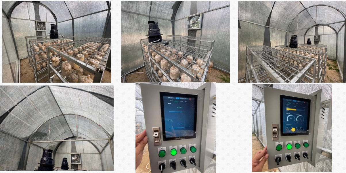
ภาพที่ 7 พัฒนาโรงเรือนระบบปิดแบบ EVAP และติดตั้งตู้ควบคุมระบบภายในโรงเรือน
